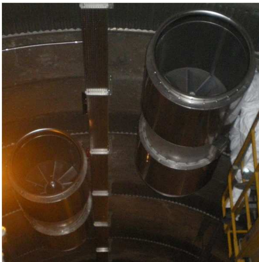
Installazione di una coppia di ventilatori in volta
