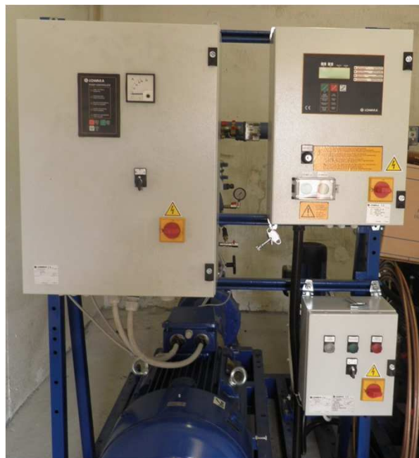
Galleria La Perosa – Particolari tubazione antincendio a marciapiede e gruppo di pompaggio
