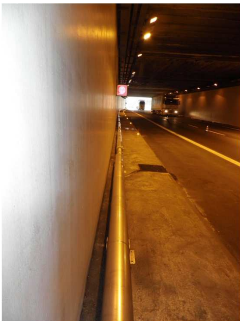
Galleria La Perosa – Particolari tubazione antincendio a marciapiede e gruppo di pompaggio
