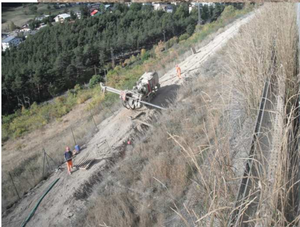
Foto 1-2 – Realizzazione consolidamento banche terre rinforzate
