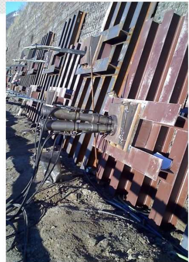
Foto 3 – Esecuzione tesatura tiranti
