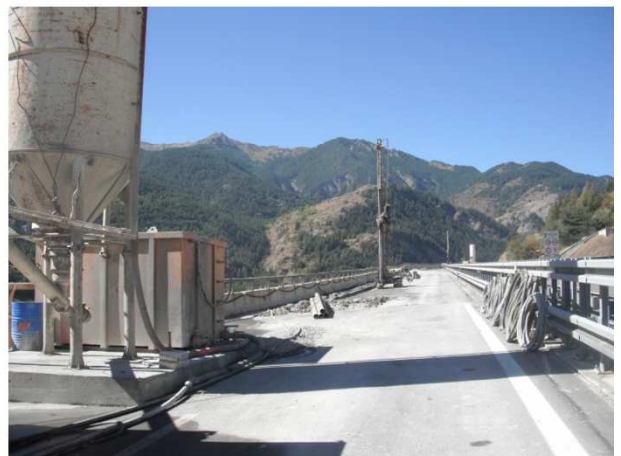
Foto 4 – Realizzazione consolidamento da piano viabile
