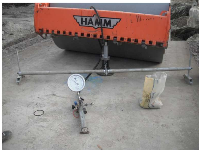
Foto 4 - Esecuzione prove di piastra su rilevato realizzato
