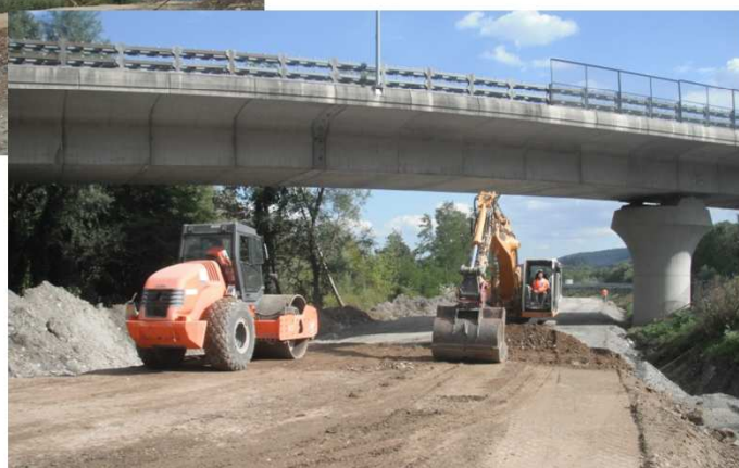
Foto 1-2 - Realizzazione rilevato arginale
