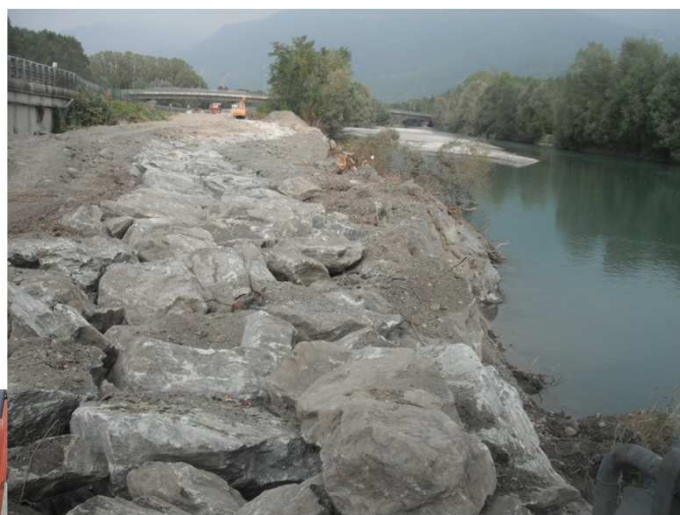
Foto 3 - Realizzazione scogliera a protezione della scarpata arginale
