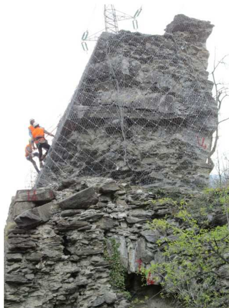
Foto 1-2-3 – Posa in opera di sistema di protezione passiva
